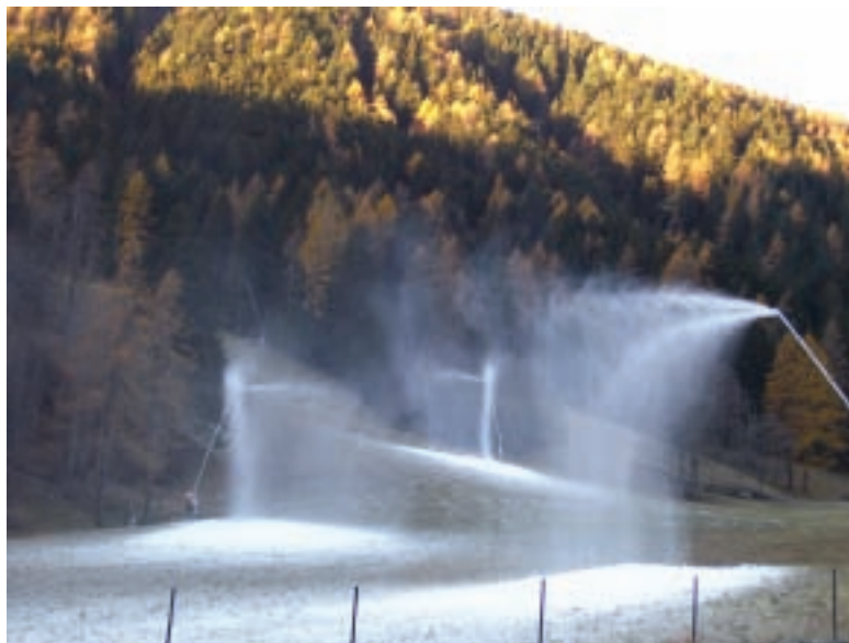
Da sinistra in senso orario: *Mai più senza: la stagione sciistica al Weissmatten ha ora neve assicurata; *Schermata del programma di gestione Sufag relativo alla stazione di pompaggio di carico e compressore; *Cielo terso, temperature marginali, produzione neve Sufag ottimale
